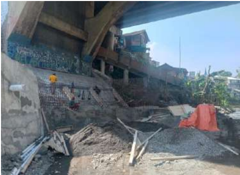
Pekerjaan Talud Terban RW 02
