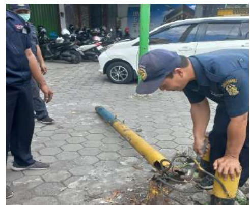
Penggantian tiang APILL yang rusak
