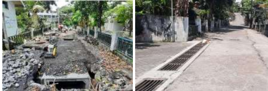
Perbaikan SAH Jalan Gambirsawit
