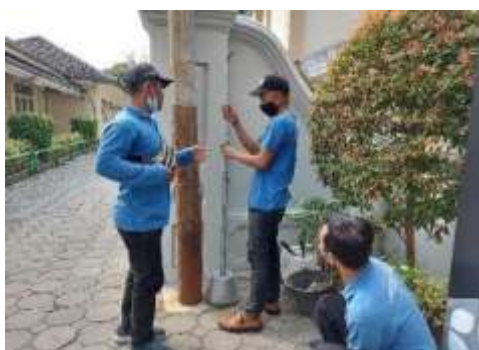
Pemasangan alat uji kualitas udara passive sampler
