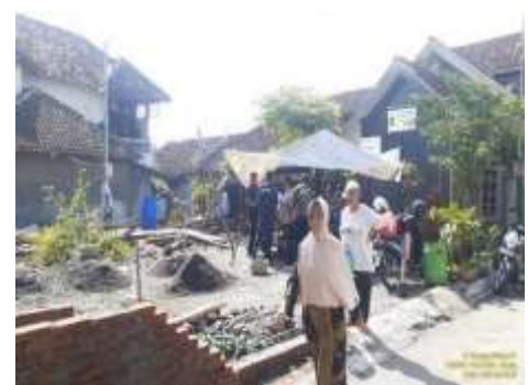
Pembangunan RTHP Keparakan Ngejaman
